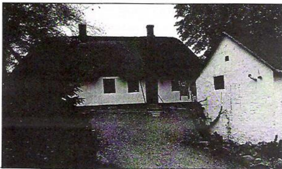
Lindgårdsvej 6A - Mårslets ældste hus fra 1778
